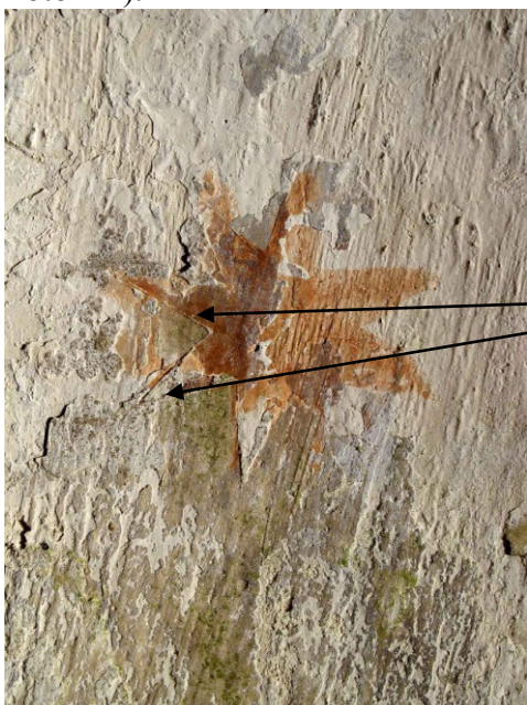
Foto 12. Restaureerimisel on tähekesed jäetud osaliselt katvate lubjakihtide alt välja puhastamata ning originaalmaaling on paljastunud hiljem restaureerimisaegse rekonstruktsioonimaalingu alt.
