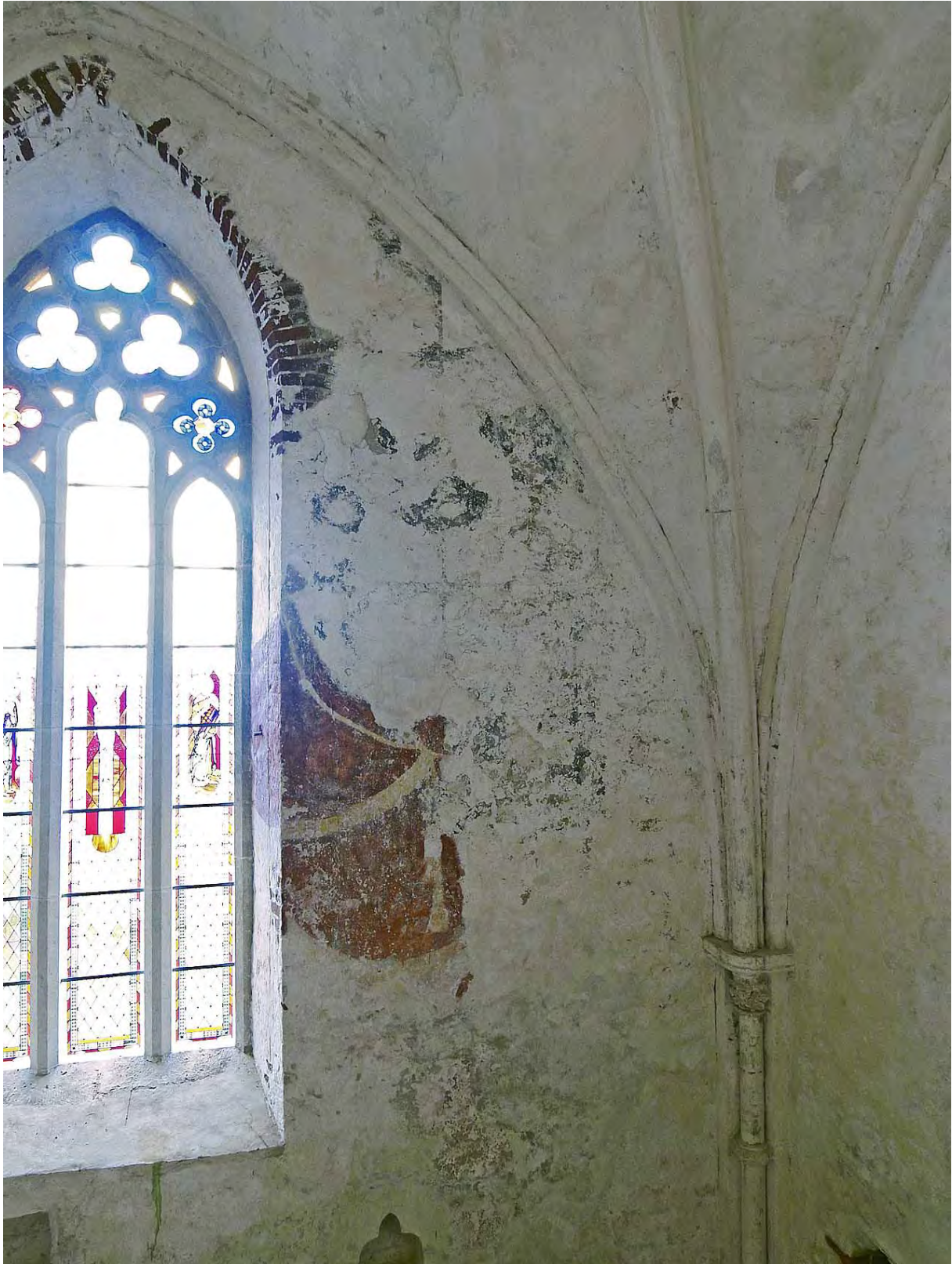
68 Kooriruumi idasein aknast paremal. Punase „draperii“ kõrval on paljandunud „marmoreeringut“.
