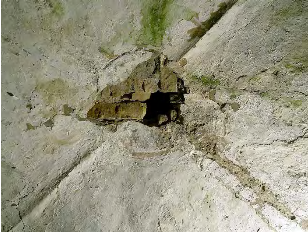
27 Läänevõlviku võlvi keskosa maalitud päiskivi katke ja teravselgseks modelleeritud servjoontega.
