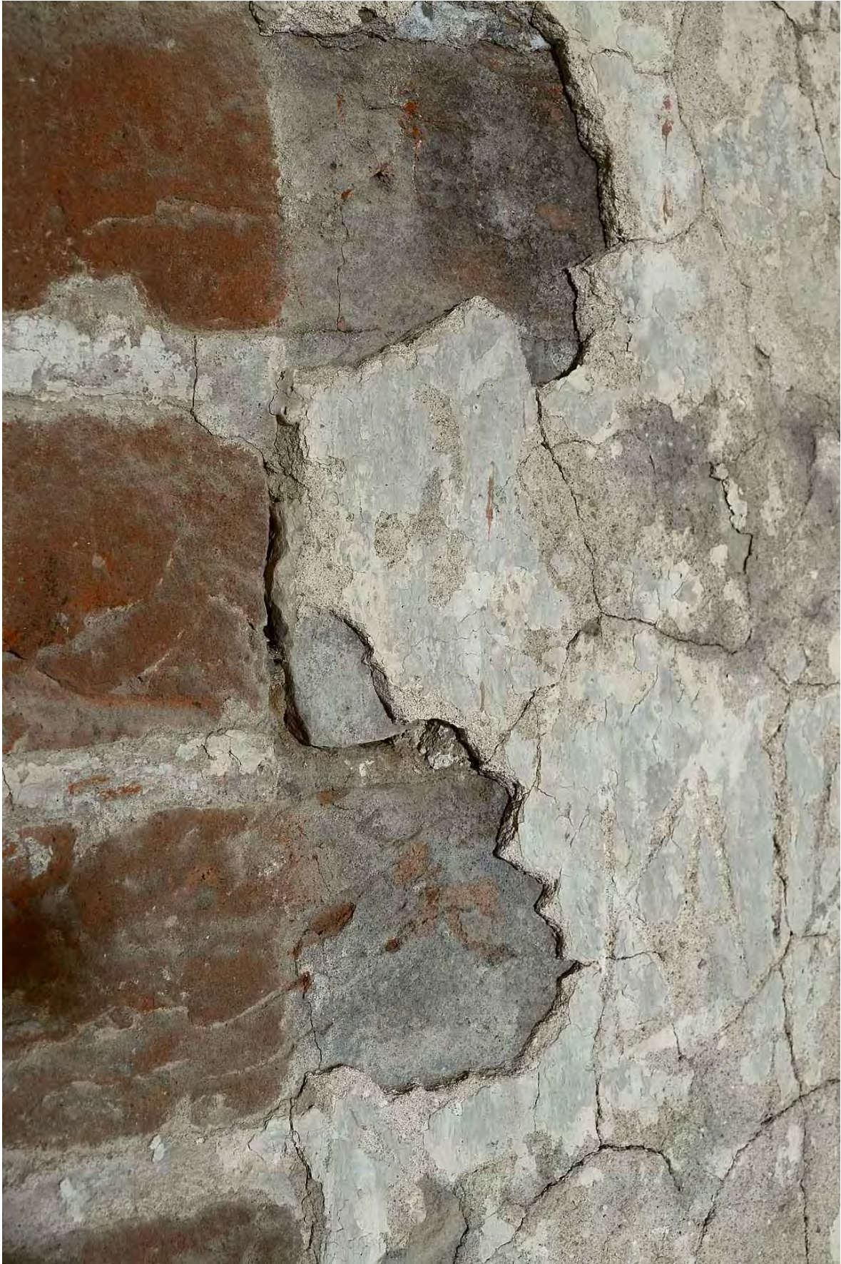
74 Portaali paremal küljel on tellistel punast värvi, vuugid on passtoosselt valgeks värvitud. Edasi on seinapind valgeks värvitud, kuid halliks tahmanud.
