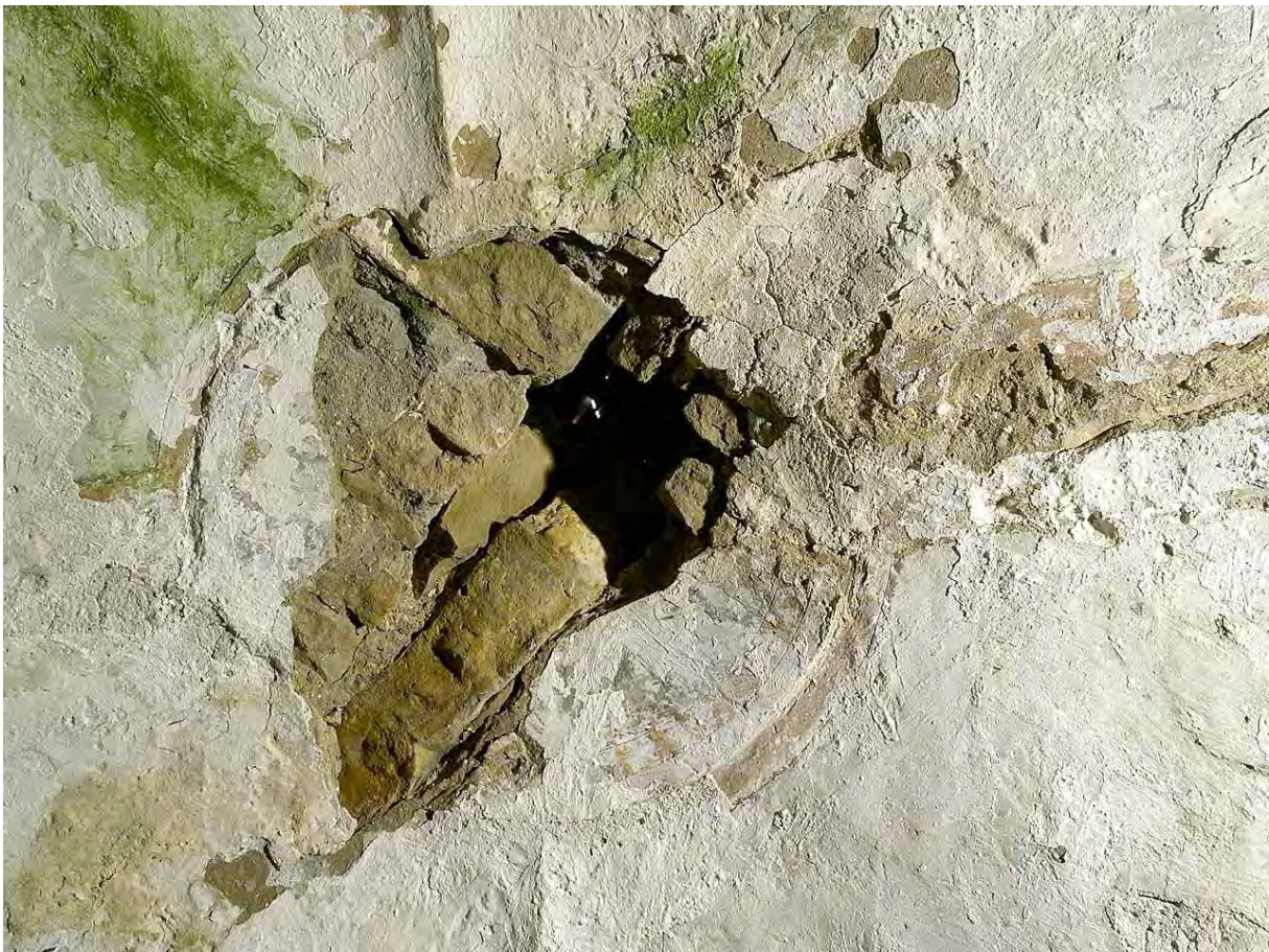
28 Detail eelmisest. Näha on „päiskivi“ krohvi sisse tõmmatud alusjoonist ja „roiete“ pastosseid valgeid „vuuke“.
