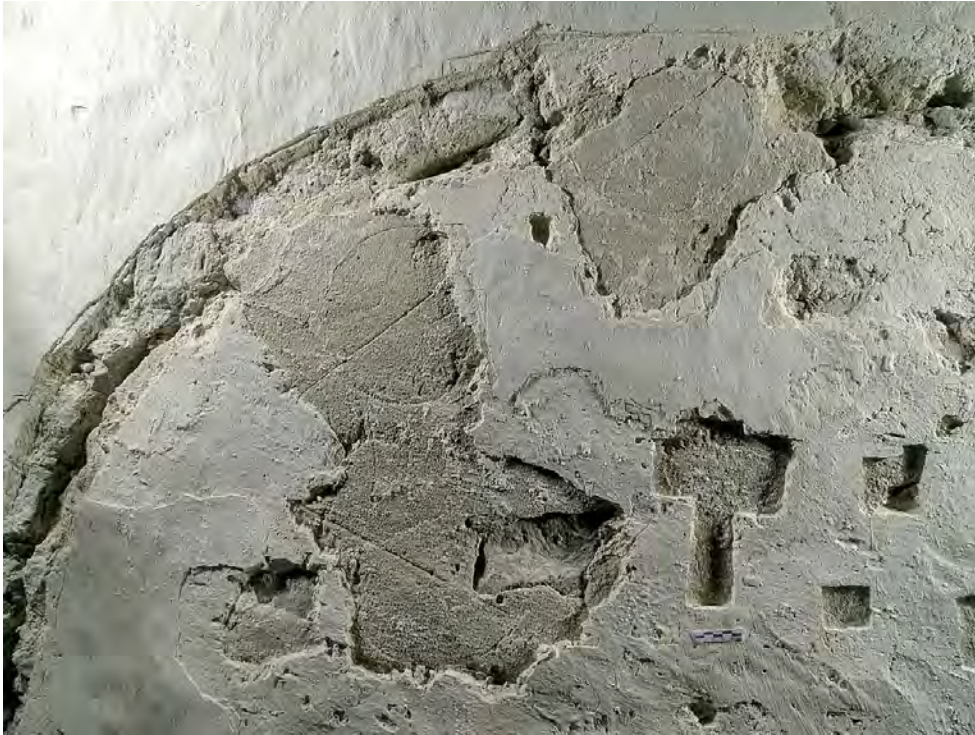
35 Siirudega ringi sirklijoonis ja ettetõmmatud teljejooned krohvil.
