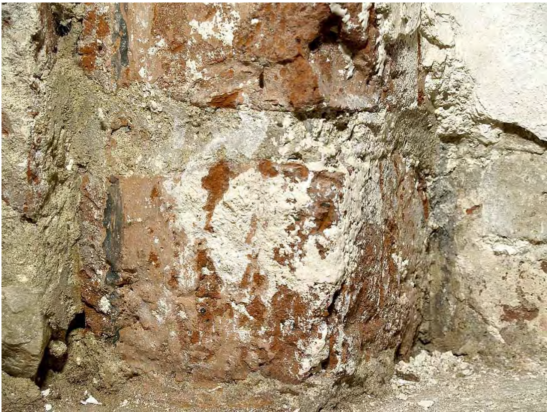
21 Detail üle-eelmisest. Võlvi servjoonel on kvaadermaalingu fragmendid.
