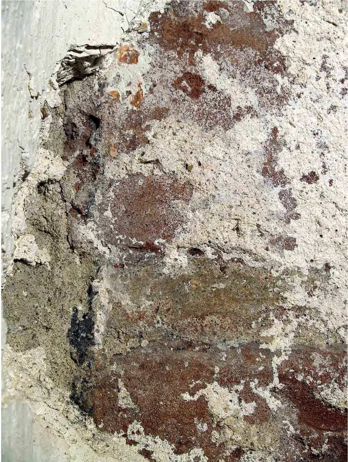
24 Detail eelmisest. Näha on punase värvi kübemeid ja „kvaadreid“ raamustavat musta joont.
