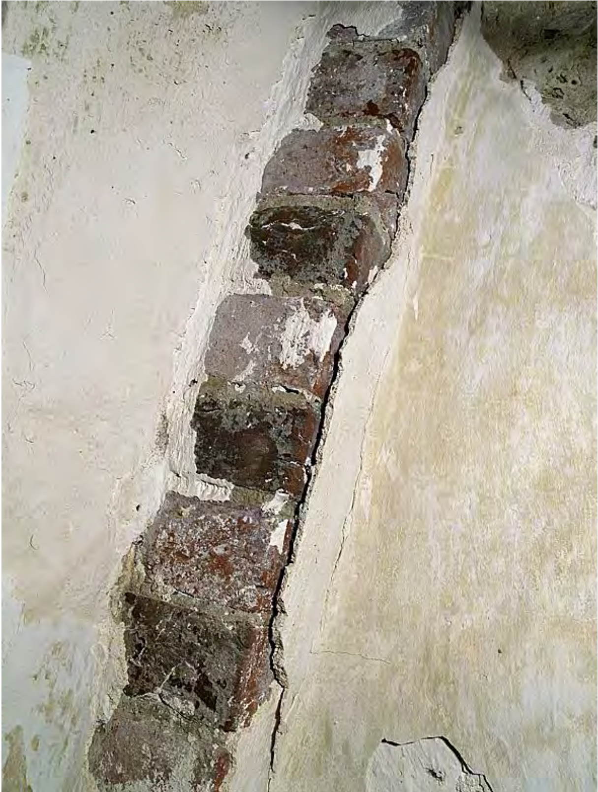
25 „Värviline“ telliseladu pikihoone idavõlviku kilpkaare tõusul. Tellised olid algselt punaseks värvitud.
