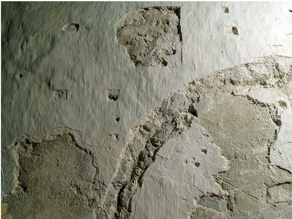
38 Põhisondaži alast vasakule jääv ala kaarjoontega ja ülemine sondaž halvasti säilinud gooti krohviga.
