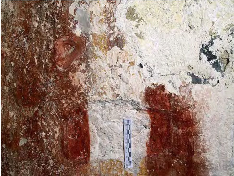
71 Detail draperiist 1995. a krohviparanduste ja toneeringutega.
