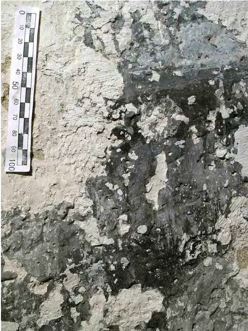
77 Aluspinnast irdunud ja kohati pulbristunud „marmoreering“ on väga halvast seisukorras.
