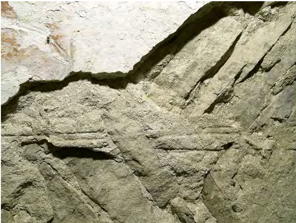
12 Servjoone krohvi alumine kiht ettetõmmatud servjoone sihiga.
