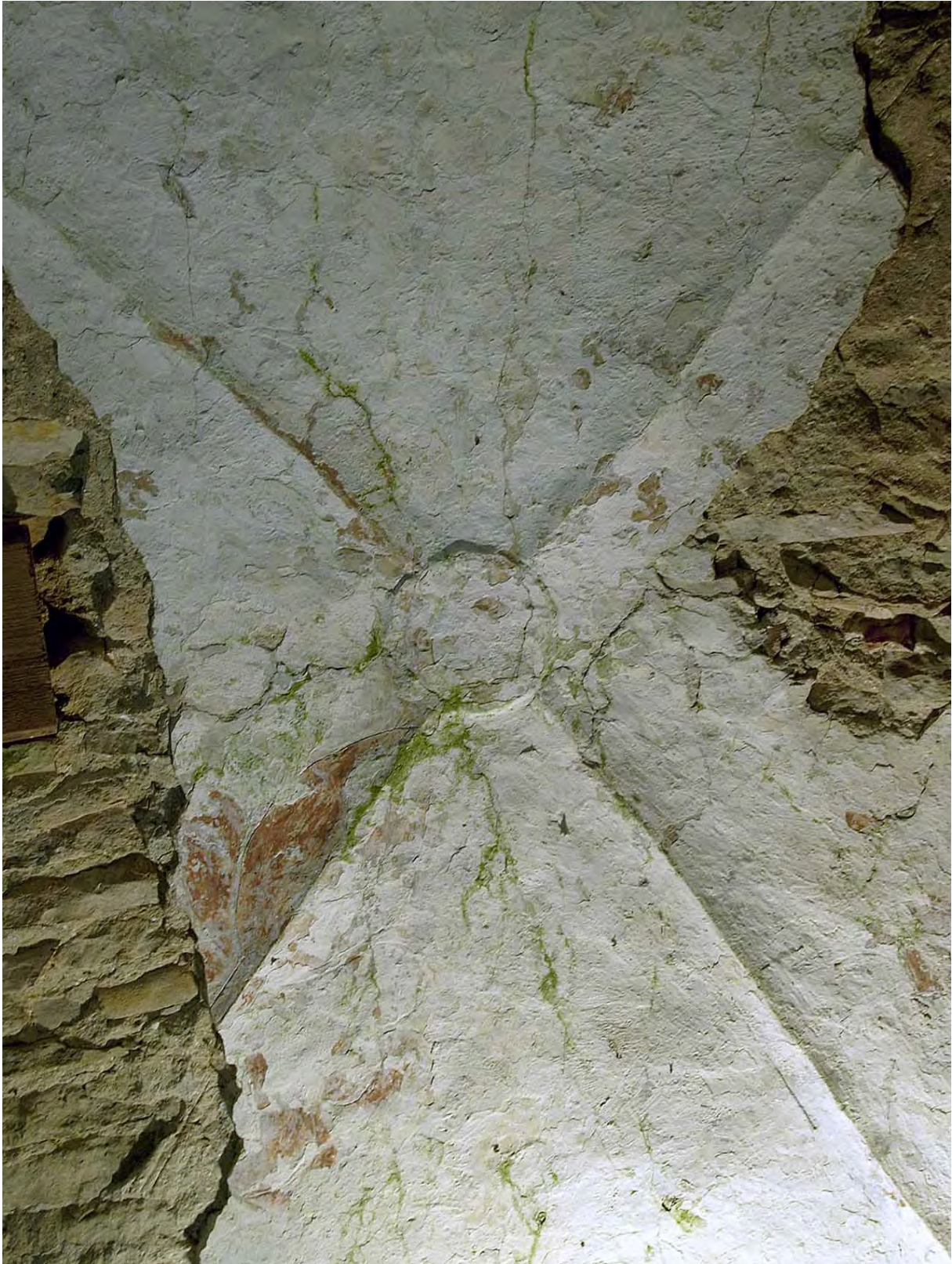
10 Reljeefne „päiskivi“ ja teravselgsed servjooned. Maaling on paremini loetav „päiskivist“ allpool.
