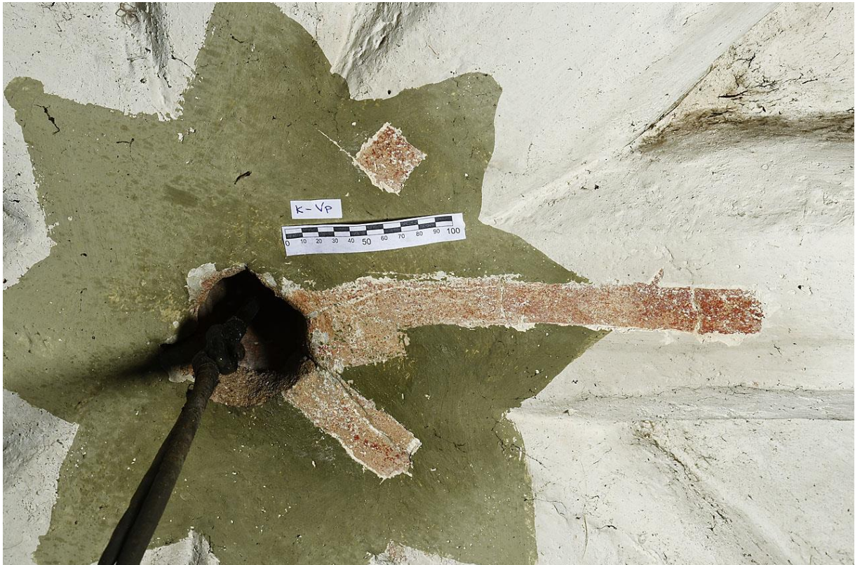
7. Koorivõlvi päis. Pealmises kihis pruunikasroheline täht 1936. a remondi ajast, alumises kihis roiete punane maaling. Foto P. Säre.
