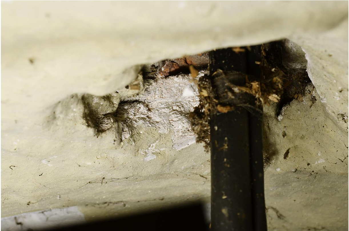
11. Pikihoone 5. võlviku lühtririputusauk. Näha on tellis ja kaks krohviikihti. Foto P. Säre.
