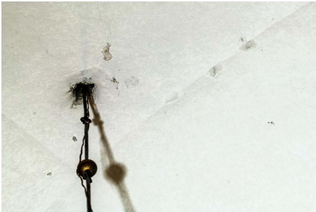
10. Sondažid pikihoone kesklöövi idapoolseima võlviku võlvipäises.
