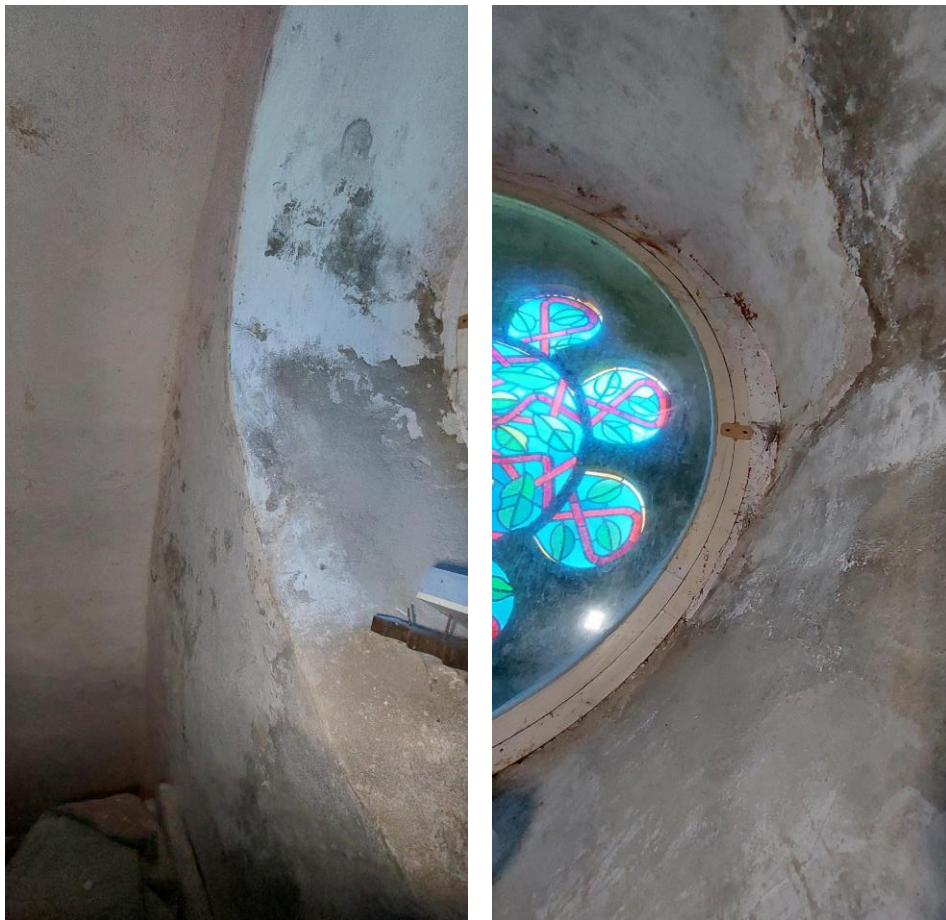
13. Olukord lääneseina roosakna ümbruses. Ulatuslikud tsementkrohviparandused ning seinte niiskuskahjustused on hävitanud varasemad viimistluskihid.
