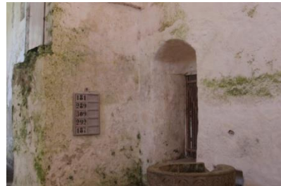
vetikas horisontaalsetel pindadel (toitained tolmust?)
