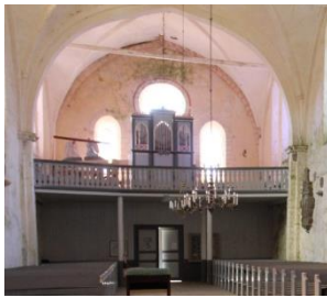
võlvide vajumine, seinad ülevalt väljapoole kaldu
